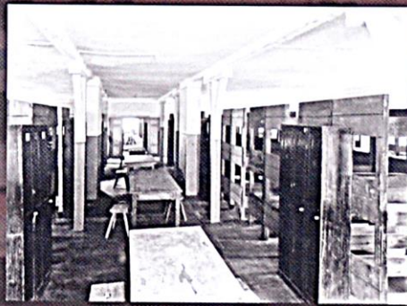
Interiér obytného bloku v Osvětimi I
